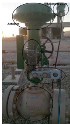
شکل شماره ۸. شماتیک یک شیر کنترلی globe (سمت راست) با محرک پیستونی و اجزای اصلی یک شیر کنترلی کارخانه فیشر (سمت چپ)
